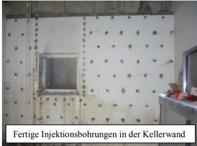
Fertige Injektionsbohrungen in der Kellerwand
